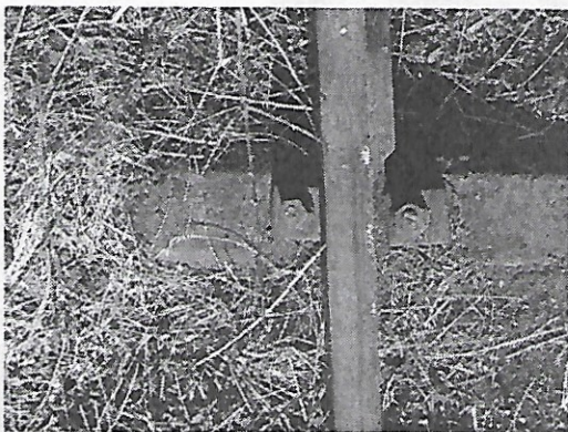
Pohled na spoj kolejnice s kovovým pražcem
